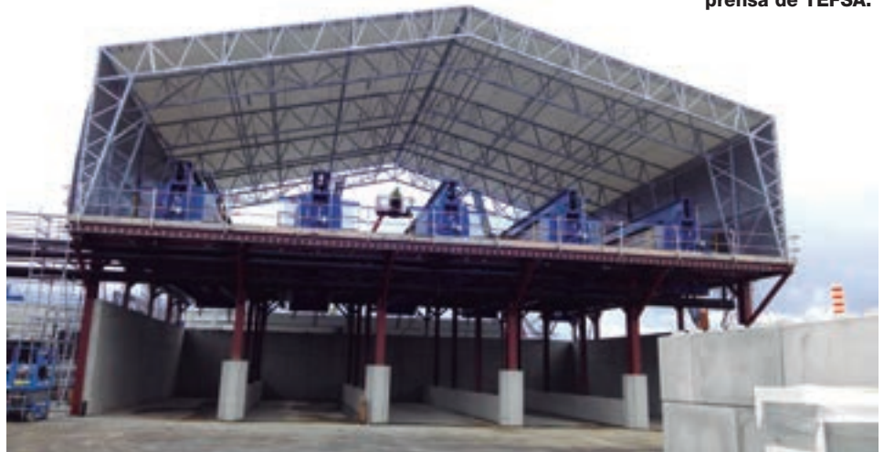
Batería de filtros prensa de TEFSA.
